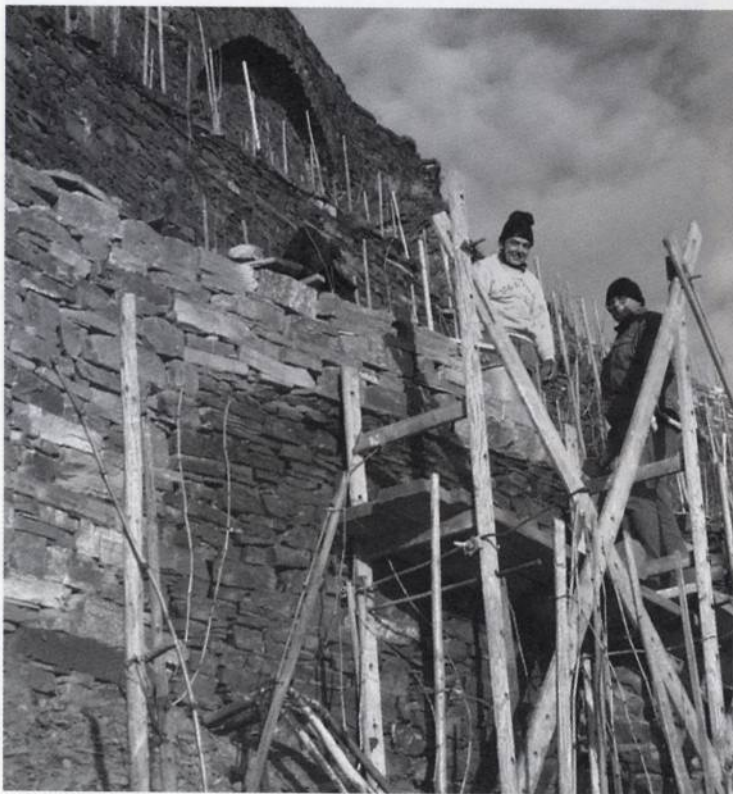
■ Beim Mauern ohne Mörtel wird Handwerk zum Kunsthandwerk. Trockenmauern aus den barten, quarzitägen Schiefern können über 300 Jahre alt werden
